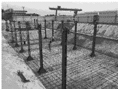
图4 预埋钢吊带安装
